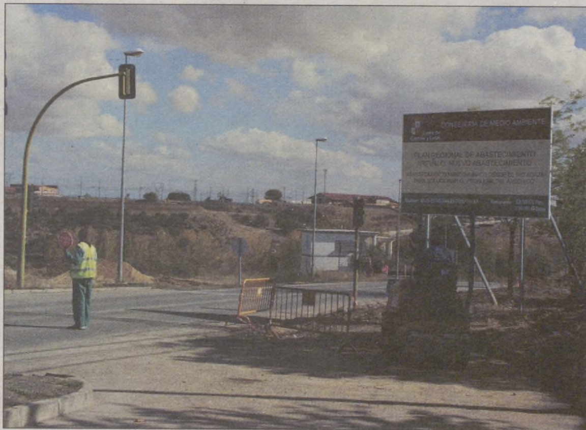
Obras de la potabilizadora de Arévalo próximas al puente de San Julián.
