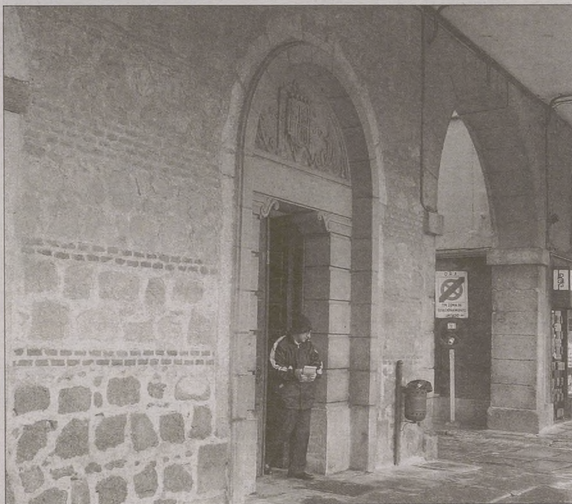
Fachada principal del Servicio Municipal de Urbanismo.
