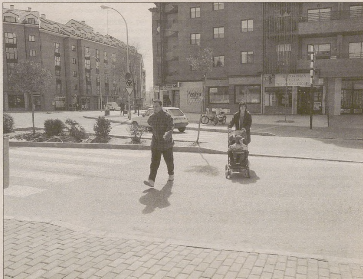
Paso de peatones de Juan Pablo II que no se corresponde con el lugar donde se ha rebajado la acera / ENRIQUE
