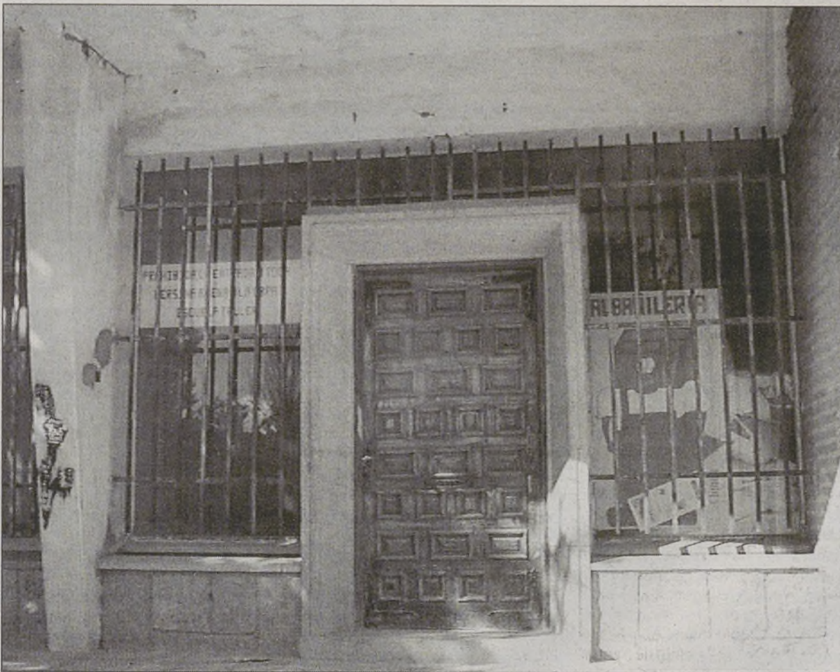
Desde esta entrada se accederá a la Recepción y a la Cafetería de la hospedería / HUERTA
