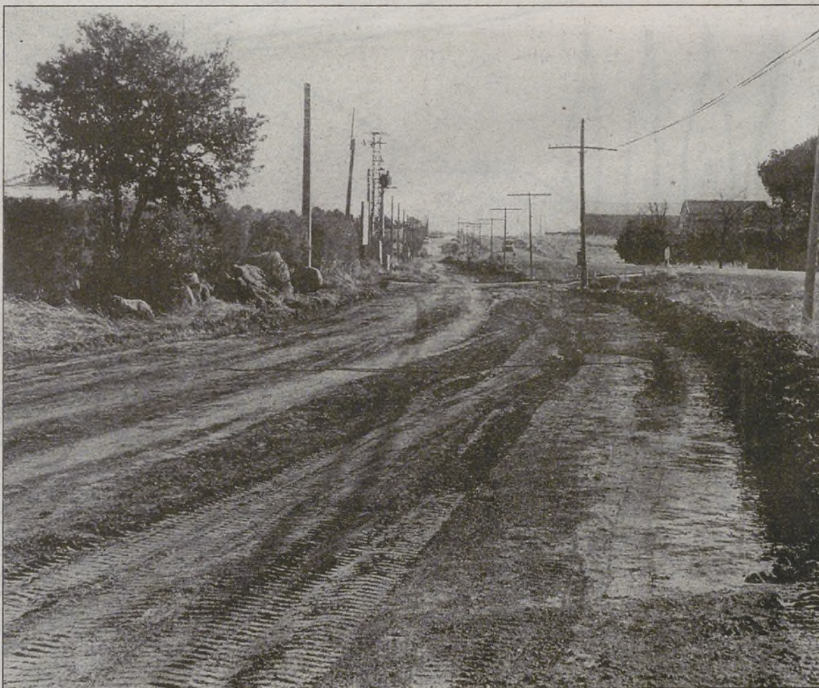
Desvío provisional que será asfaltado esta semana / ENRIQUE
