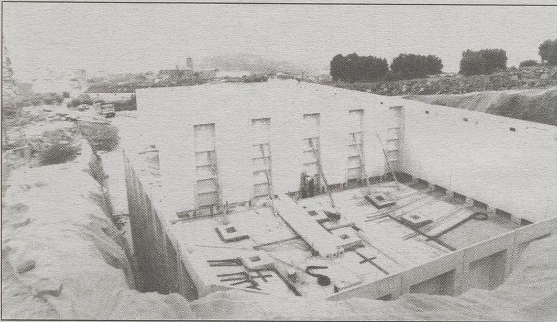
Obras del primer depósito de Cebreros en construcción, con capacidad para 6 millones de litros de agua.
