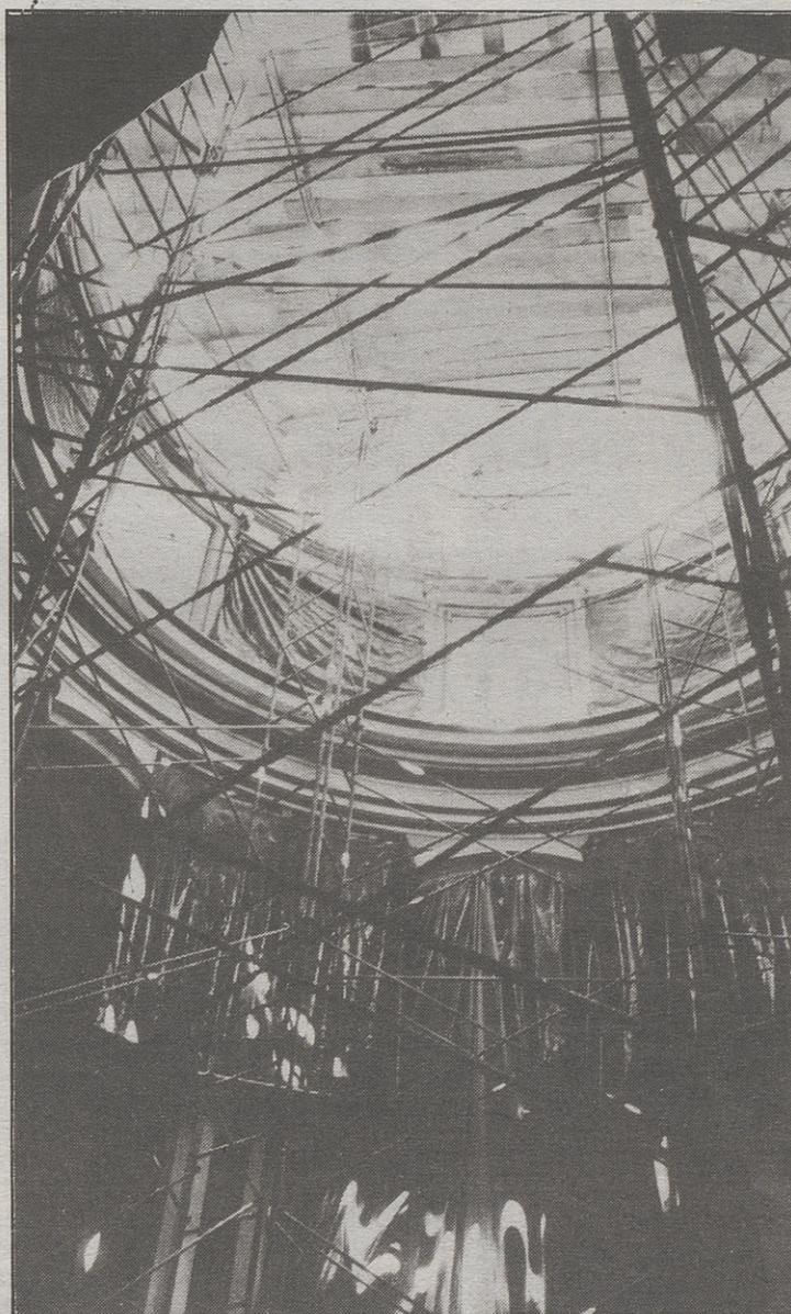
Estructura metálica colocada en el interior de la Capilla de la Virgen de la Portería, como andamio. LUMBRERAS
