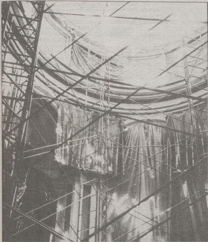
Ya ha quedado instalado el andamiaje de la parte interna de la Capilla. El próximo paso será el de la colocación de la estructura metálica de la cúpula. LUMBRERAS
