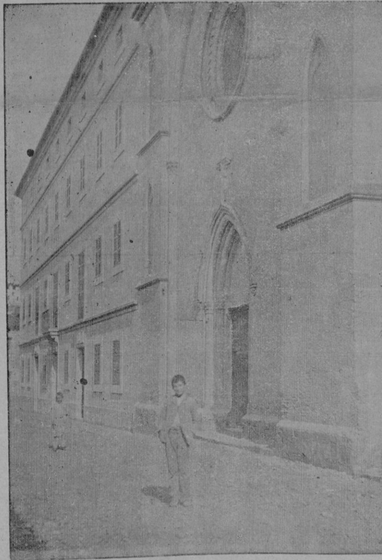
Vista de la fachada principal del edificio.
