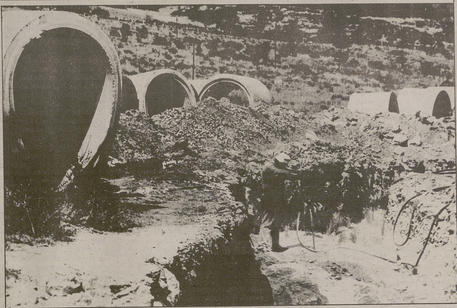
Se iniciaron las obras de los colectores para la depuradora de Avila.
