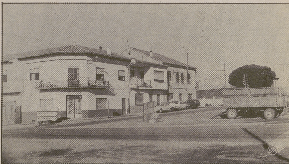
Barrio de la Estación, donde se efectúan las obras de alcantarillado
