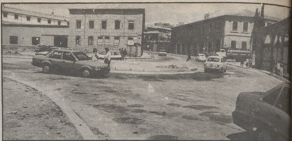
Estado actual de las obras
