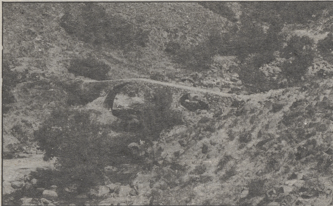
Puente Nuevo, sobre el Arroyo del Infierno.
