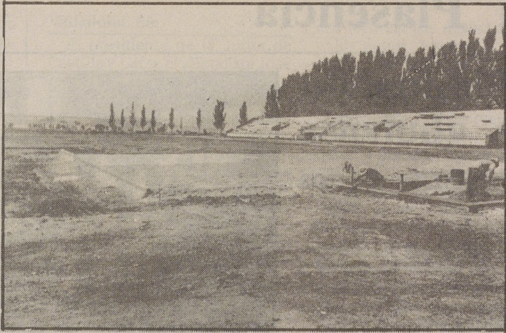
Las obras del Polideportivo comenzaron a un buen ritmo. Luego estuvieron un año paradas y ahora parece que volverán a continuar los trabajos en esas pistas de atletismo. LUMBREAS
