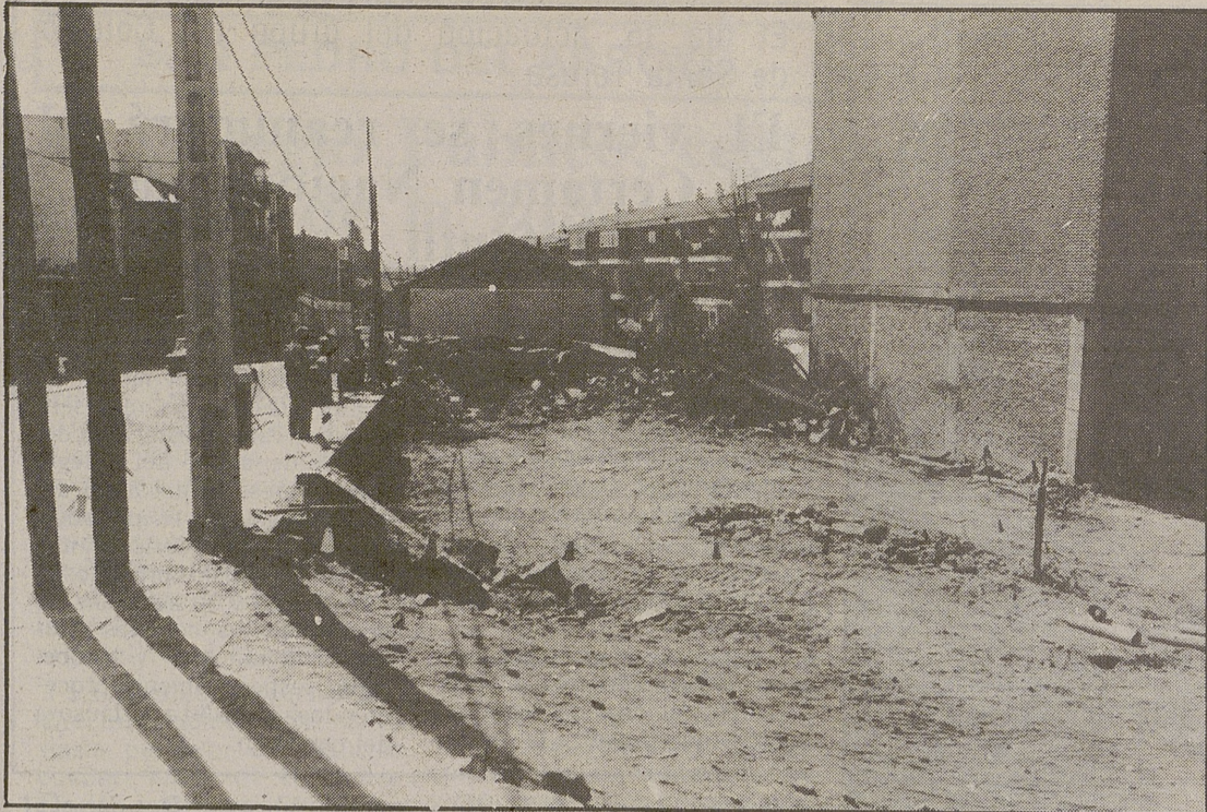
El solar de las viviendas será recuperado para la apertura de la calle y construcción de un nuevo edificio. LUMBRERAS
