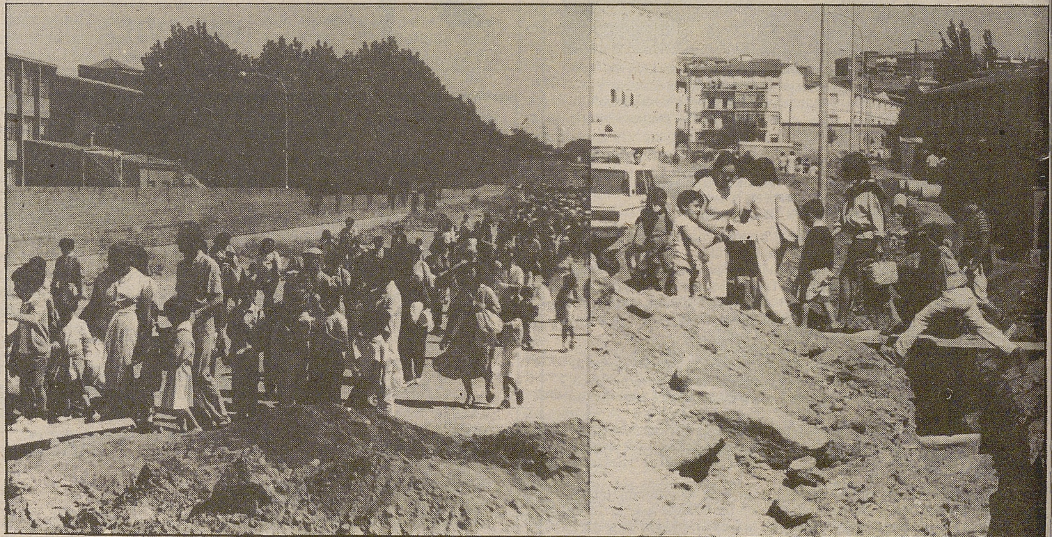
La zanja provoca grandes colas de personas que necesitan atravesarla. MAYORAL.
