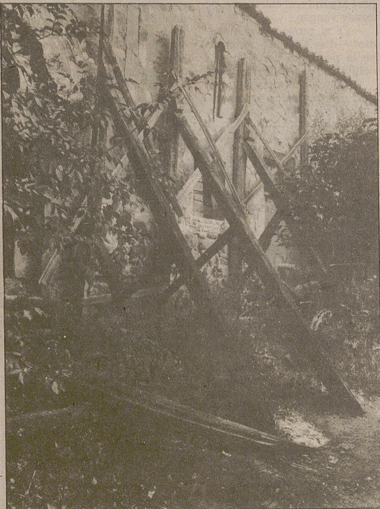
Se inician las obras de restauración del Episcopio
