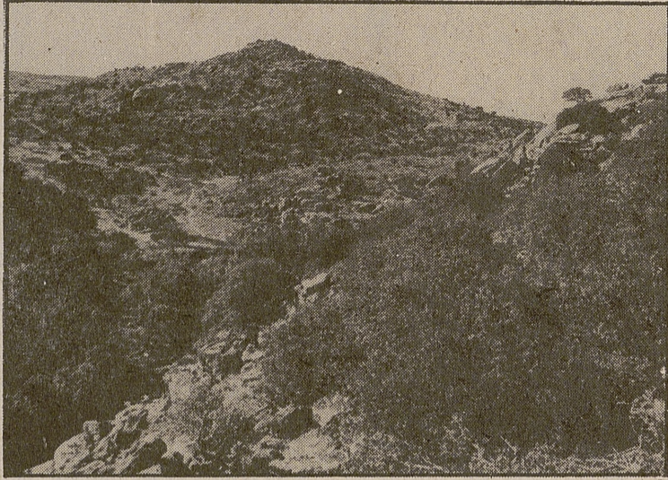
Entre el cerro de "Las Cogotas" y otro en Yonte se construirá el muro de la presa. LUMBRERAS
