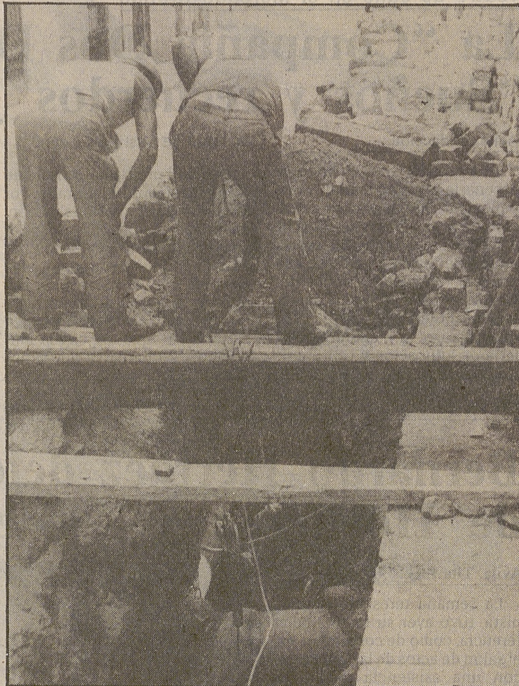
Los trabajos han interrumpido la circulación
