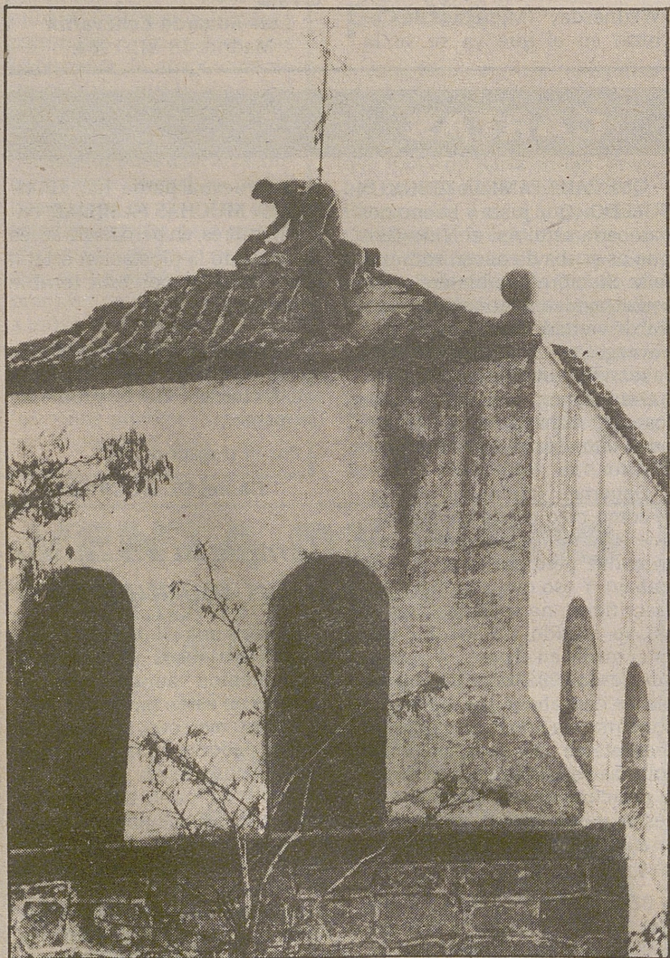
Se repara la cubierta de la torre de Santo Tomé.
