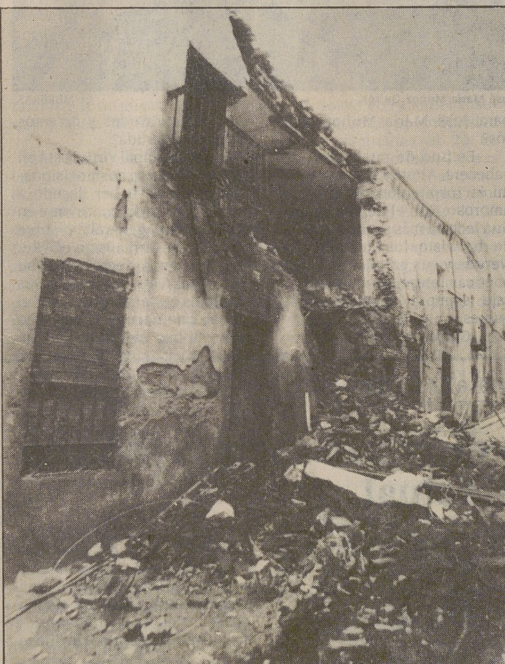
Toda la fachada de la casa cayó sobre la calzada
