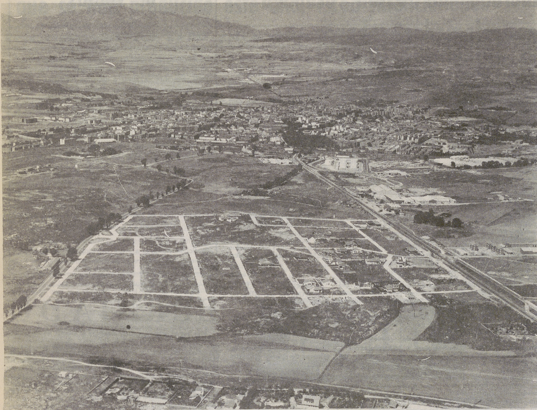
Vista aérea de Las Hervencias. (2.ª fase)
