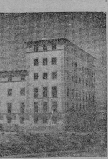
Una de uno de los bloques de viviendas protegidas que el Ayuntamiento está terminando de construir en nuestra ciudad (Foto CASTELL)
