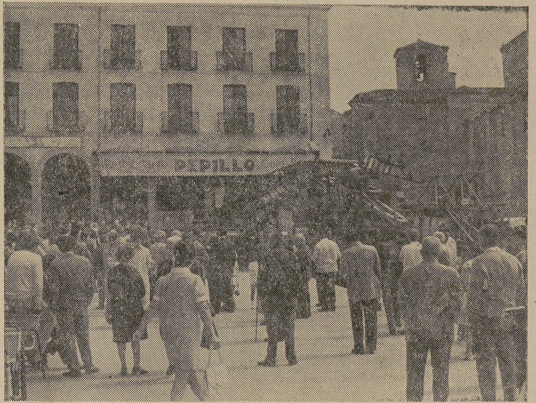
Los paseantes mañaneros que ayer estaban en el Mercado Grande, presenciaron un espectáculo con el que no contaban: la operación de descarga de los camiones en que había sido transportada una grúa torre para las obras que se realizan en el solar de la esquina con la calle Estrada. Un espectáculo singular que llegó a congregar en torno a los camiones a casi medio centenar de personas. (Foto: LUMBRERAS).
