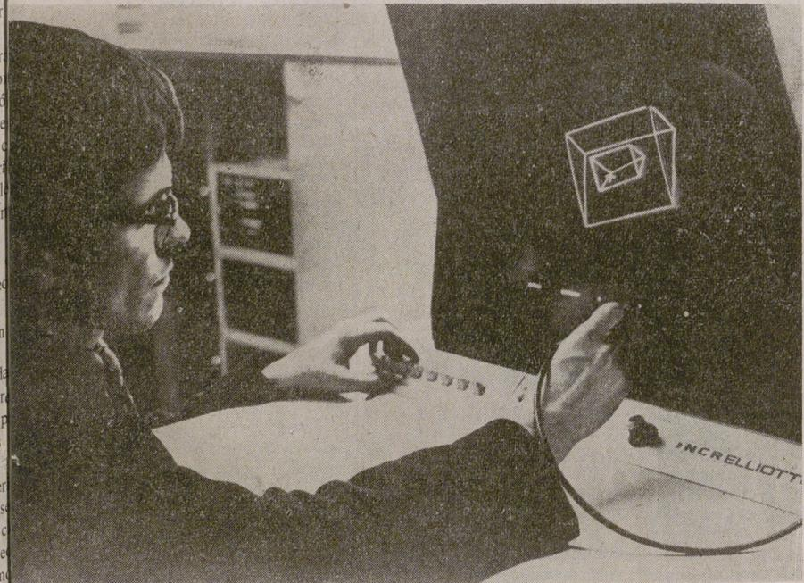
Científico de la «Elliott Automation Co.» ensaya la «pluma electrónica», con la que se pueden diseñar, en un corto espacio de tiempo, los planos de complicadas estructuras arquitectónicas. FOTO EUROPA PRESS
