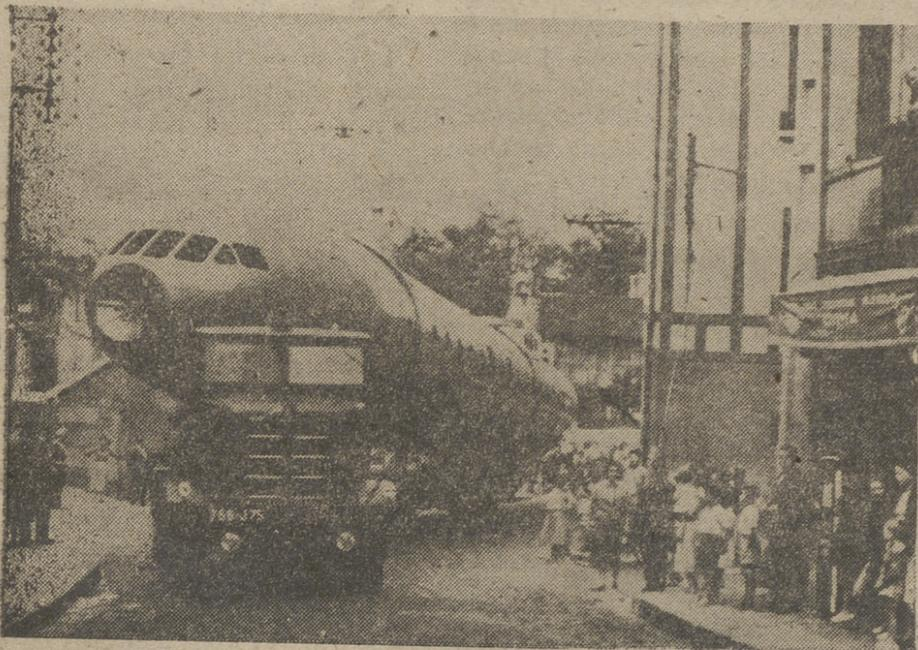
Con el fin de experimentar la resistencia del avión francés «Caravelle», un fuselaje entero va a ser metido en la piscina del Centro de Ensayos de Toulouse. La piscina, llena de agua servirá para comprobar cuál es su resistencia a las fuertes presiones. Se ha trasladado sobre una plataforma gigante, mayor aún que la que llevó a La Muderria la carcasa, hace unos meses.
