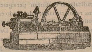
Máquina de vapor fija horizontal
