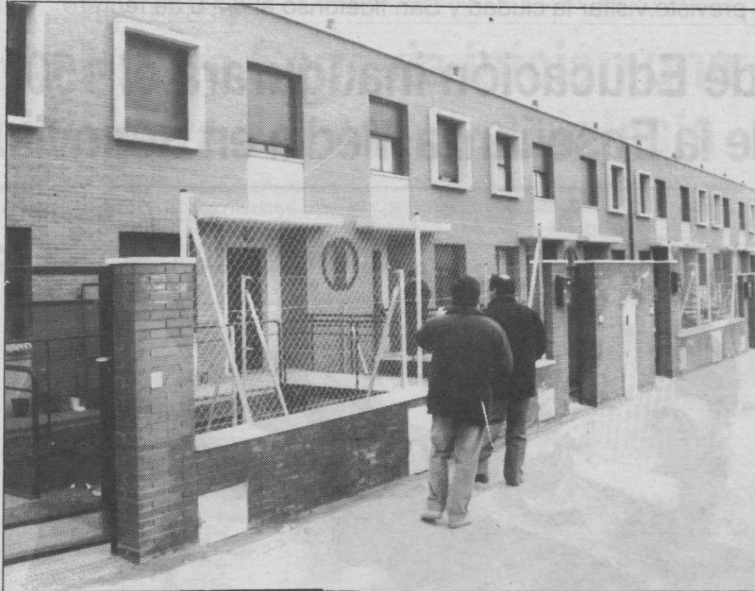
Fachada de las viviendas afectadas, en la calle Vicente Alexandre del barrio de Nueva Segovia. JUAN MARTIN
