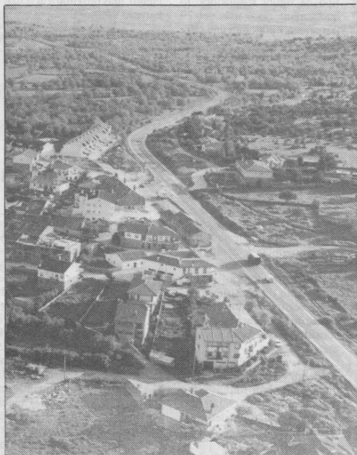
La N-603, a su paso por la localidad de Revenga.
