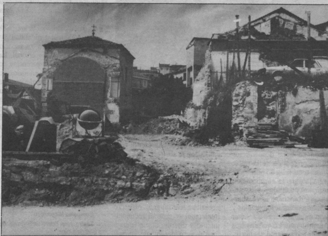
Obras de limpieza del solar del colegio, que fue fundado en 1757 para niñas huérfanas.
