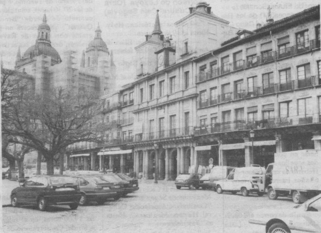
Las reformas en la Plaza Mayor comenzará con la rehabilitación de las fachadas.
