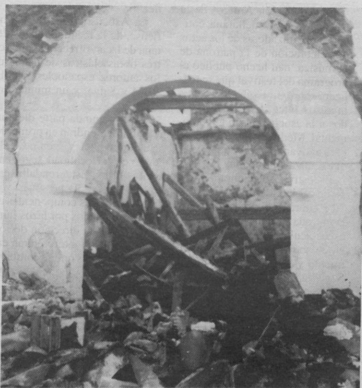
El ábside de la iglesia ha desaparecido entre los escombros.
