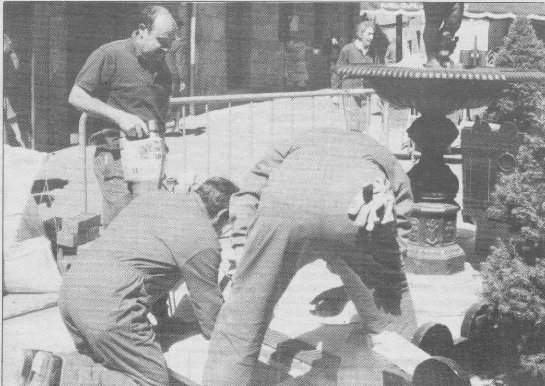
"MEJORANDO" LO PRESENTE.— La fuente del Prico continúa mejorando su aspecto, esta vez con la instalación de un pequeño sistema de drenaje que impida que el agua baje a raudales calle Real abajo. Esto supone una nueva inversión en una iniciativa que no goza precisamente del favor de muchos segovianos, que desearían tener la plaza del Corpus libre de angelotes y fuentes que no tienen una utilidad concreta.—(Foto: Peñalosa).
