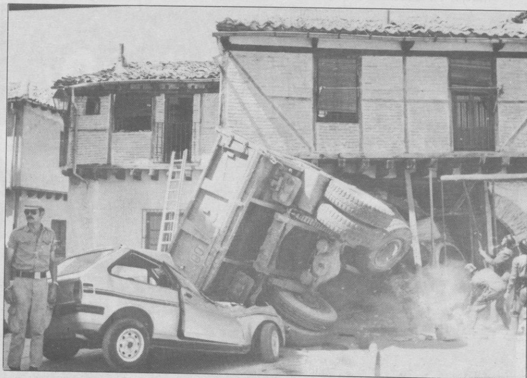
Los accidentes en zona urbana han registrado un descenso menor que en carretera.
