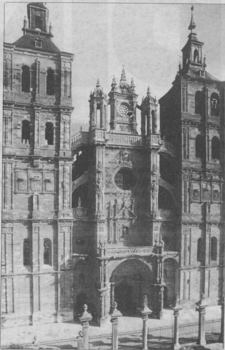
Fachada principal de la Catedral de Astorga.
