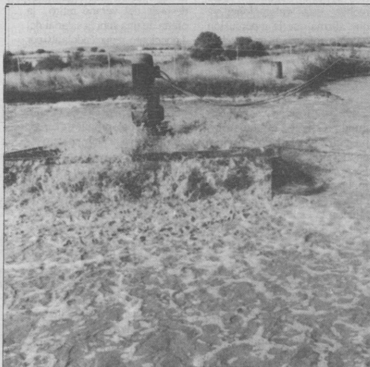
Un aspecto de la balsa biológica de la depuradora.
