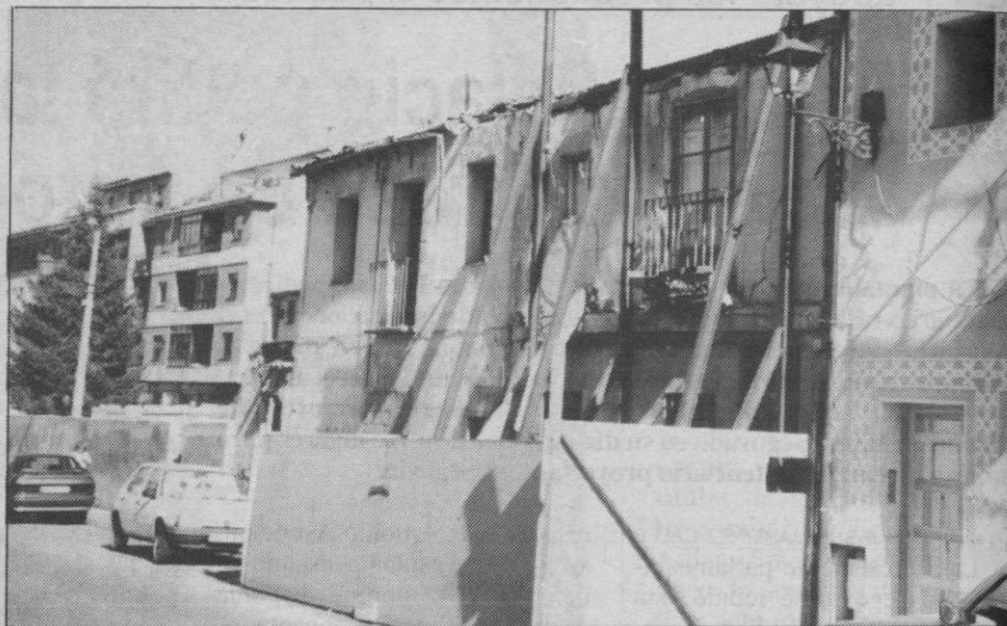
Las viviendas de la calle Teniente Ochoa, auguran ruina.
