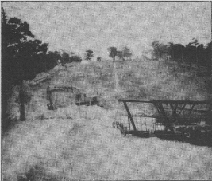
Las obras en los pinares se iniciaron ya en fechas pasadas. A.S.
