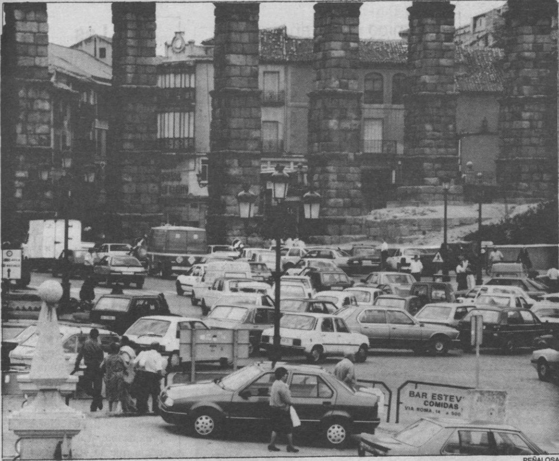
Hace ya más de un año que los coches no circulan bajo los arcos del Acueducto.
