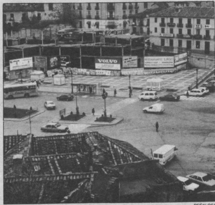
Una de las cabinas automáticas se instalará en esta plaza.
