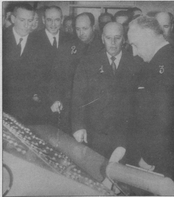
Franco inauguró en 1963 el primer túnel de peaje del Guadarrama.
