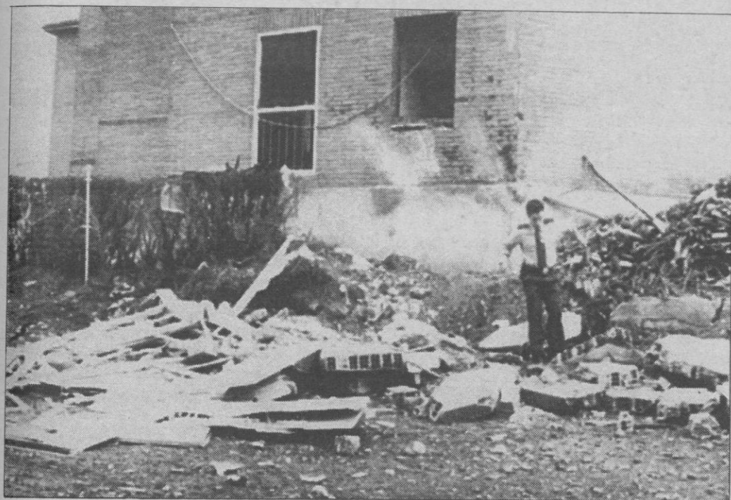
Estado en que quedó el cuartel de la Guardia Civil de Lerma.
