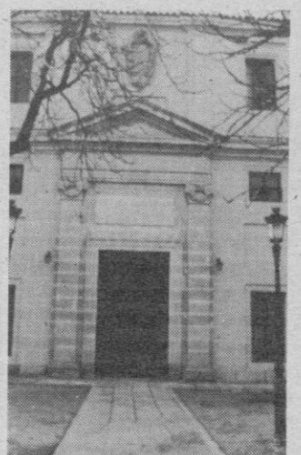
Fachada del edificio. PEÑALOSA
