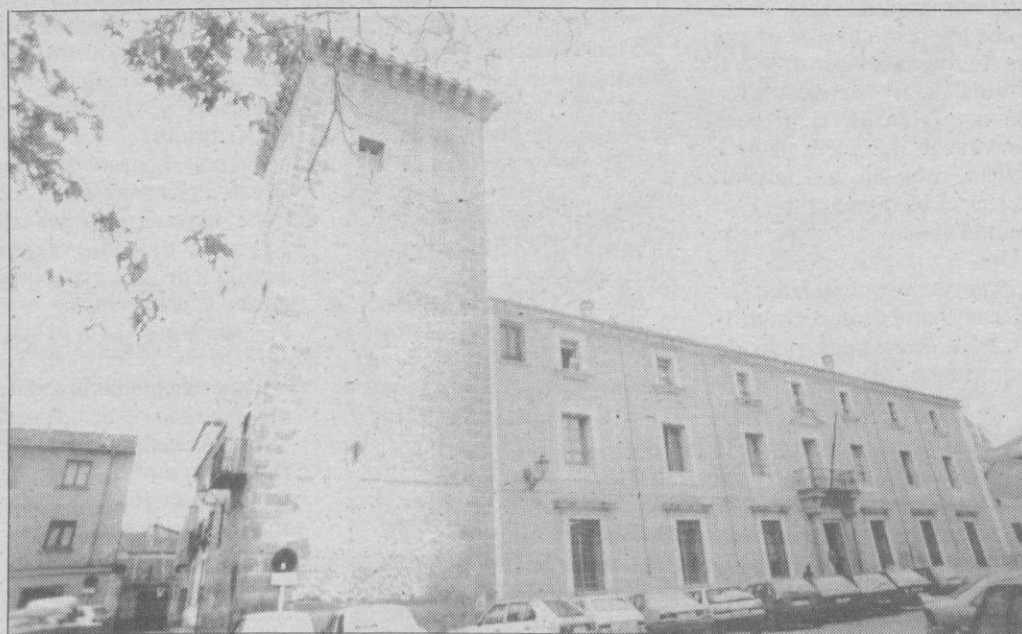
Edificio de la Delegación de Hacienda de Segovia.
