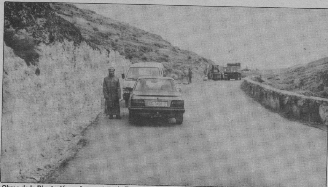
Obras de la Diputación en la carretera de Zamarramala.
