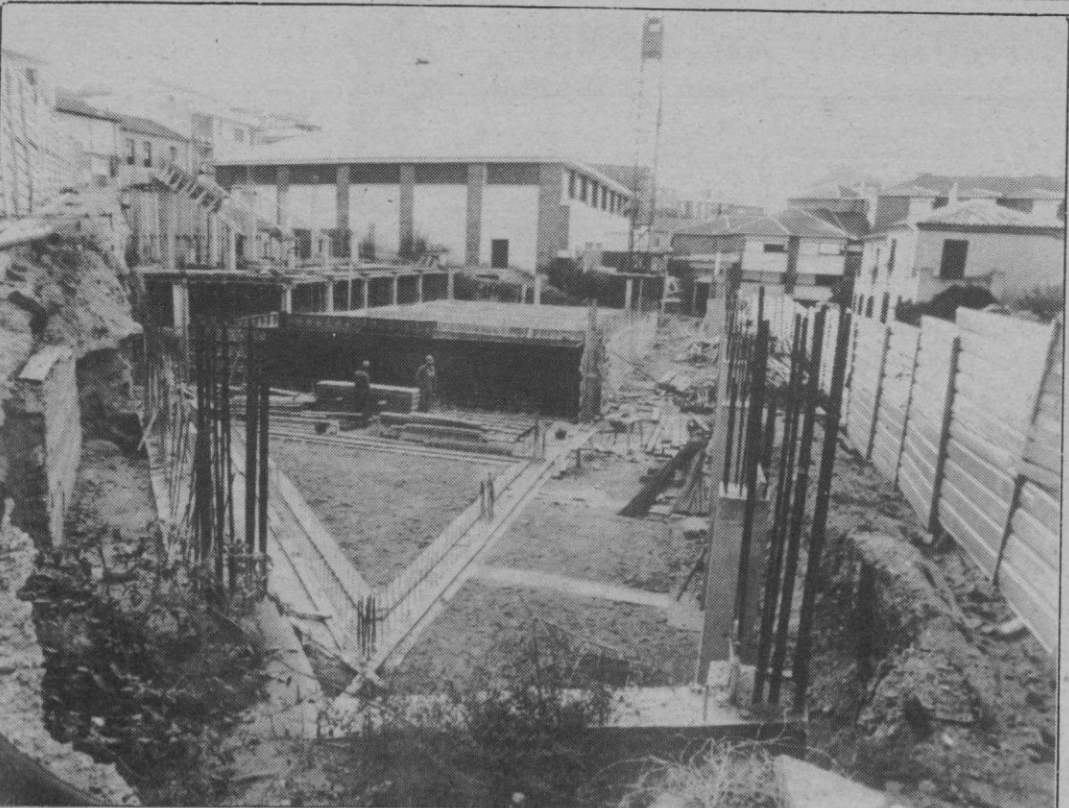
Actual estado de las obras.
