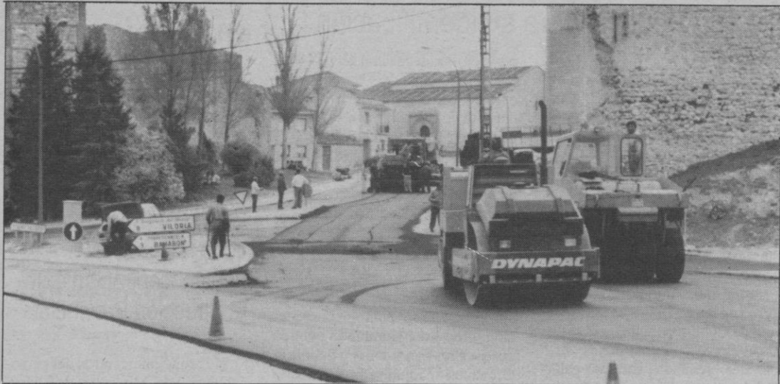
Obras de asfaltado en el cruce del Castillo
