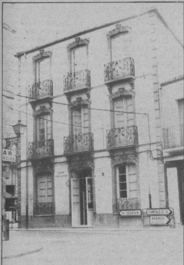
Antiguo edificio de La Cochera, sede del Casino y ahora del Centro Familiar
