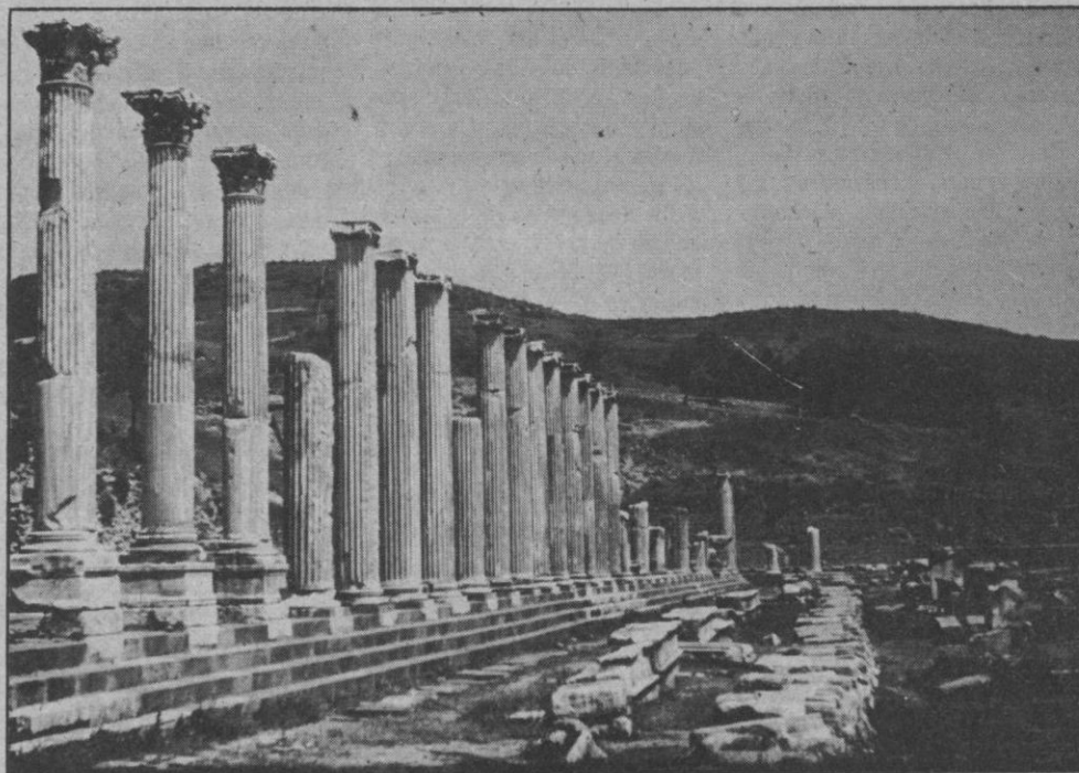
Pórtico norte de la gran plaza
