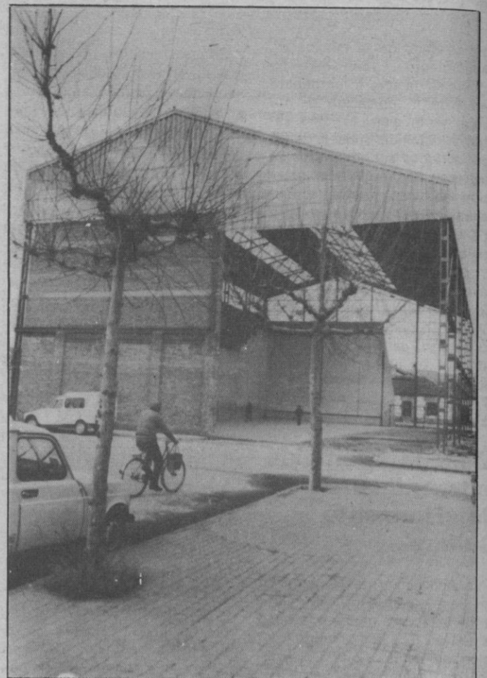
Una visita del frontón con la cubierta recién estrenada.
