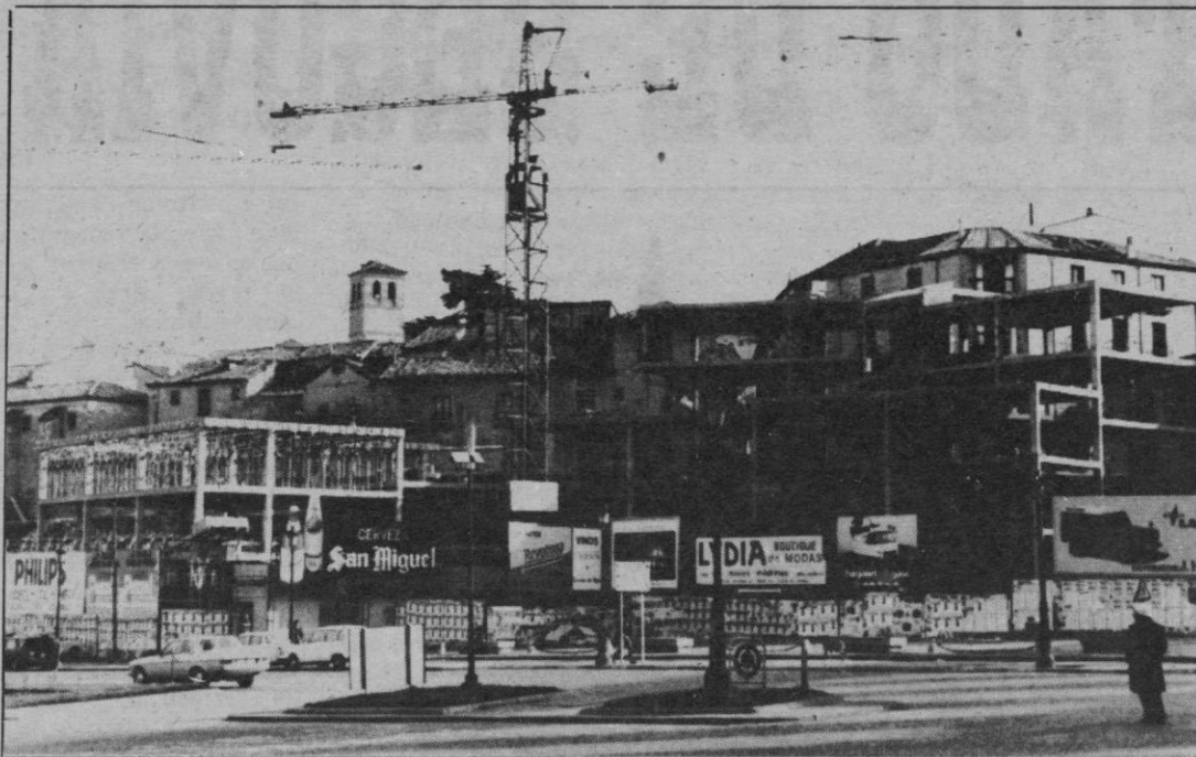
El «eterno» edificio en construcción junto al acueducto
