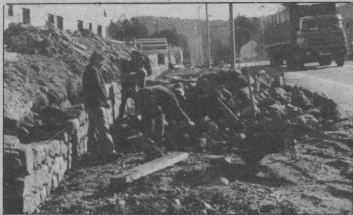
Obras de El Espinar en la calle General Franco, hasta el barrio del Egidillo.
