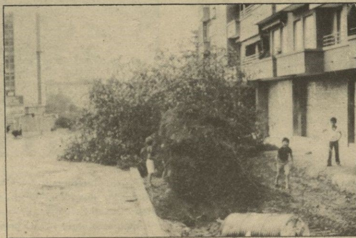
Otros daños del tráfico a la ecología
