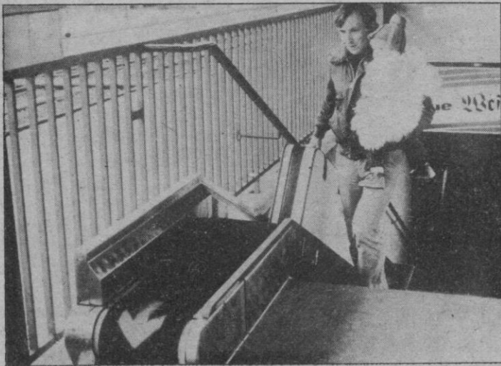
En la estación central de la ciudad alemana de Bielefeld se ha instalado una escalera rodante, que discurre paralela a la escalera de piedra para los viajeros, para el transporte de las maletas. Es muy estrecha (suficiente para el transporte de la valija) y en el futuro se construirán en aquellas estaciones de tren que por razones de espacio no puedan disponer de una escalera automática normal. Esto es en la que quepa el viajero y sus bagajes.—(Dad/DB)
