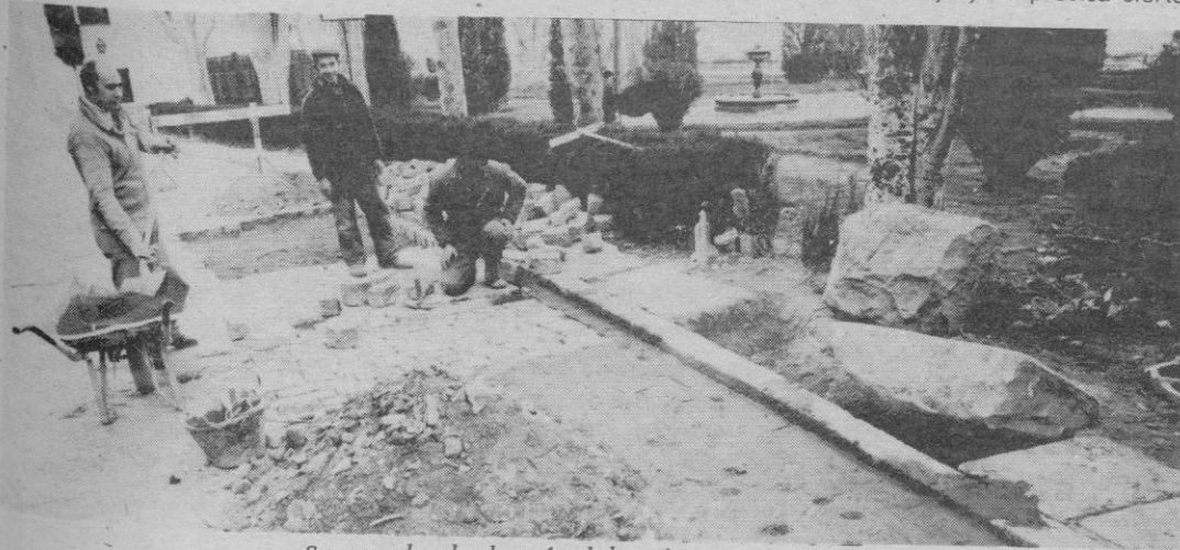
Se arregla el adoquín del recinto amurallado
