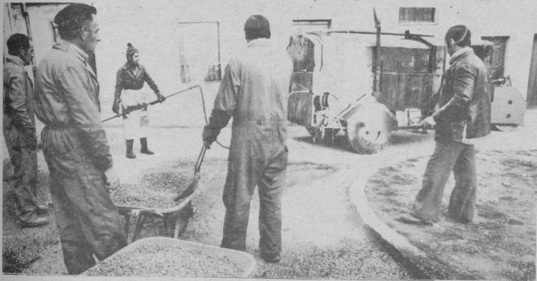
El equipo de asfalto, durante su trabajo. (Fotos: Aurelio M.)
