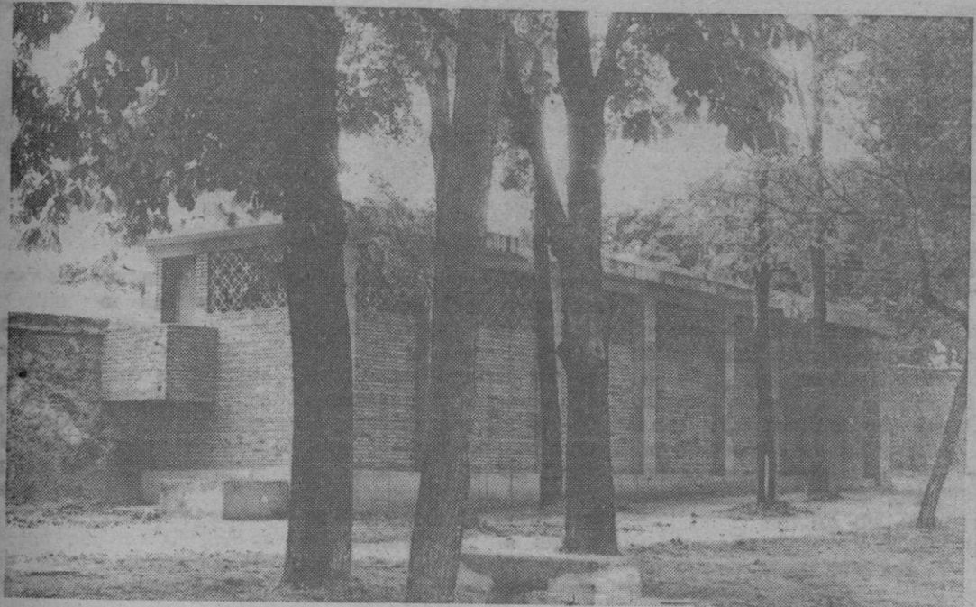
La actual depuradora no nos sirve. Se instaló ya pequeña.—(Foto Aurelio M.)
